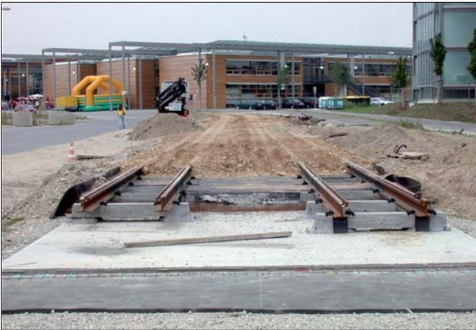
Linzer Bauweise entkoppelt durch eine dämmende Matte den Gleiskörper von der Umgebung, sowohl Körperschall als auch Streuströme werden dadurch vermieden.
