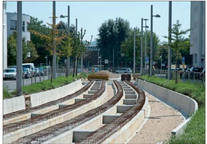
Wiener Bauweise mit Längsbalken, dazwischen ist der Boden nicht entsiegelt.
