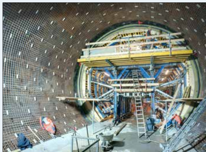
Betonieren der Innenschale
