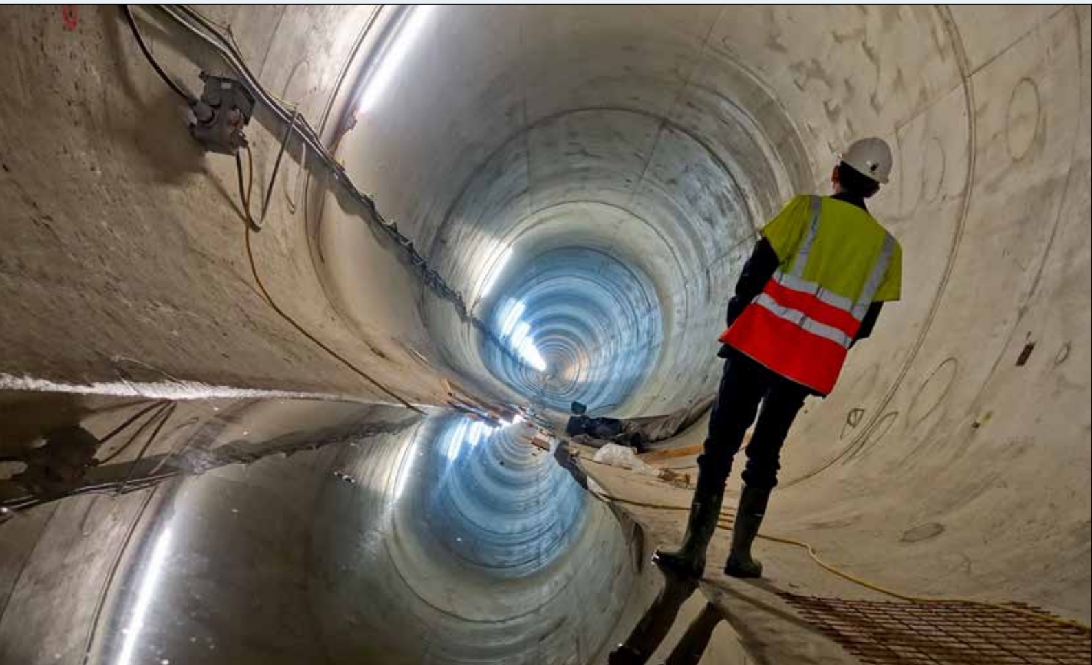
Streckentunnel in neuer österreichischer Bauweise.
