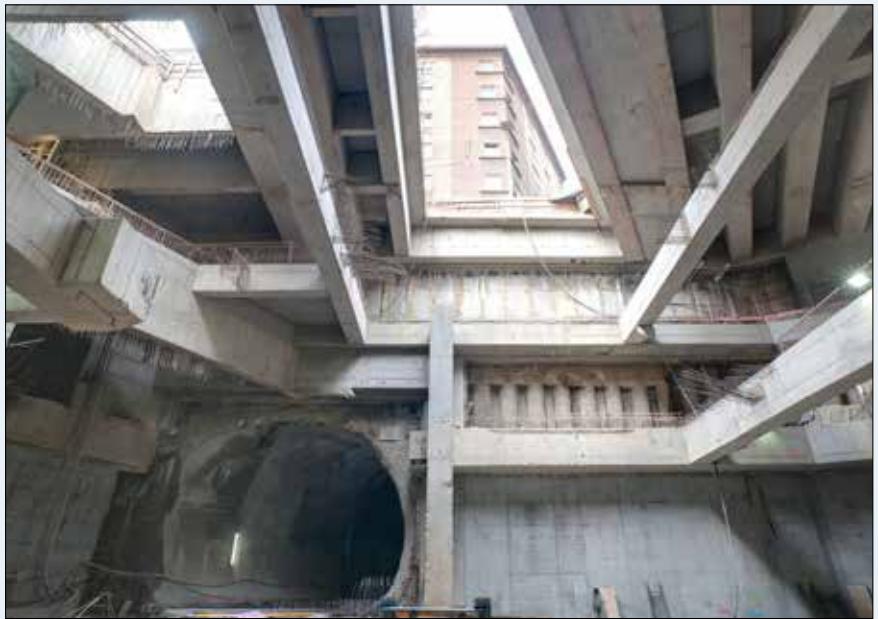
Baugrube Klausenburger Straße, links die westliche Stationsröhre
